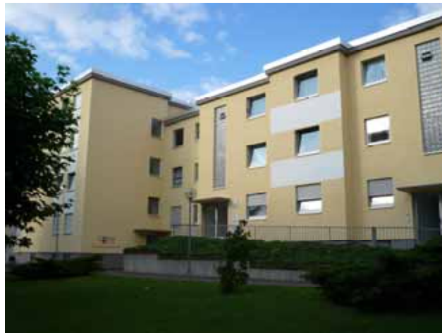
Dach und Fassade Alfred-Brehm-Straße 8
